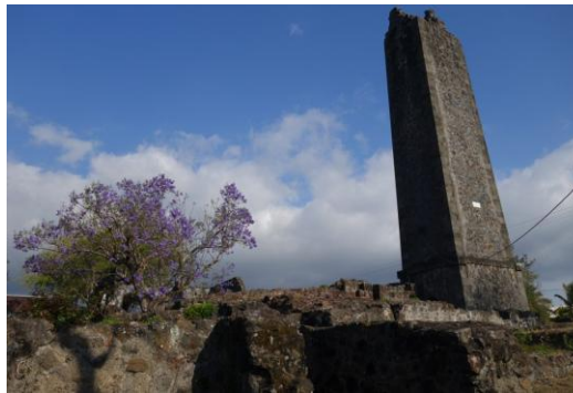
Die Ruinen der Zuckerfabrik mit Schornstein
